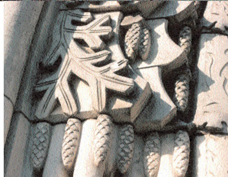
DÉTAIL Voussure sculptée à motif de pives et rameaux sur le porche du crématoire.
